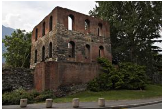
Torre di Pailleron, Aosta
